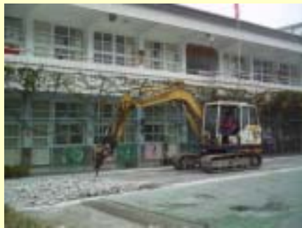
施工中照片-教室前既設pc面層打除 種-日期94.11.24
