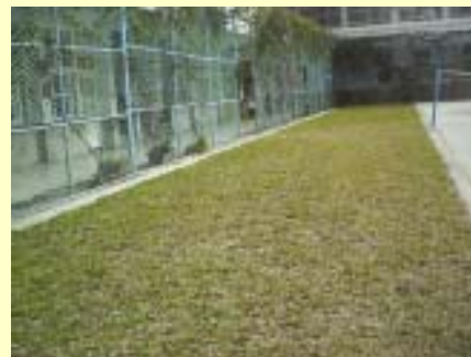
施工後照片-教室前既設pc面層打除 種植草皮日期95.1.26
