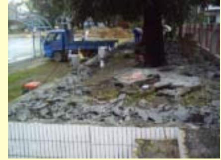
施工中照片-既設pc面層平台打除 施工中照片日期95.1.4
