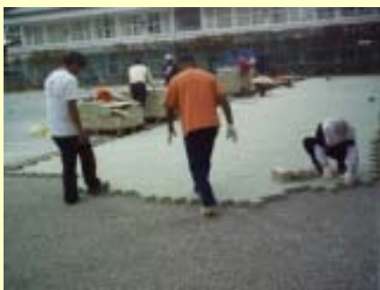
施工中照片-辦公室前既設pc面層打除 後鋪設透水磚-日期95.1.23
