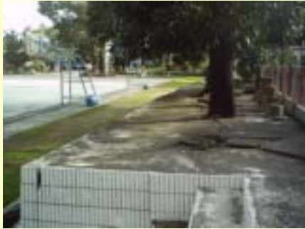
施工前照片-既設pc面層平台打除 種植草皮日期94.11.1
