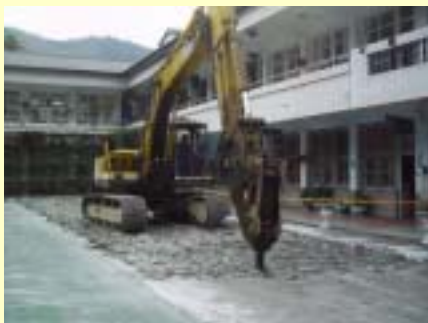
施工中照片-辦公室前既設pc面層打除- 日期94.12.24
