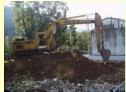
施工中照片-校門右側既設pc面層打除後利用廢土水泥塊堆成土丘日期95.1.2
