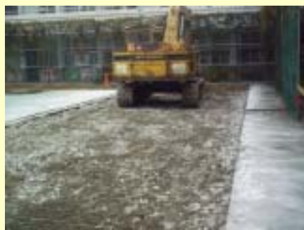
施工中照片-辦公室前既設pc面層打除 後再回填做碎石級配-日期94.12.30
