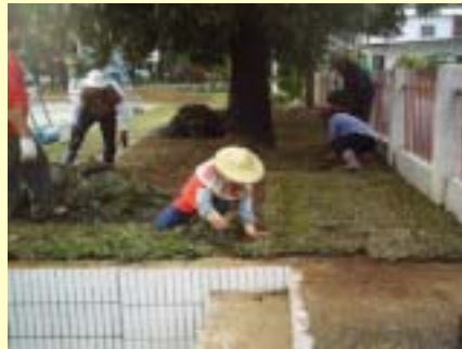
施工中照片-既設pc面層平台打除種 植草皮施工中照片日期95.1.6
