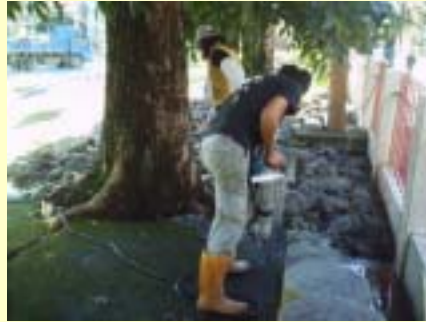
施工中照片-既設pc面層平台打除日 期95.1.3
