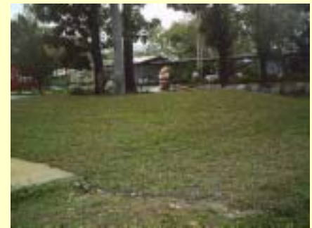
施工後照片-校門右側既設pc面層打除後利用廢土水泥塊堆成土丘種植草皮日期95.1.26
