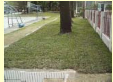
施工後照片-既設pc面層平台打除 種植草皮日期95.1.26
