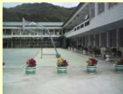
施工後照片-辦公室前既設pc面層面層 打除後鋪設透水磚-日期95.1.26
