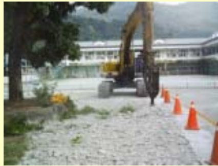
施工中照片-校門右側既設pc面層打除工中照片日期94.12.25
