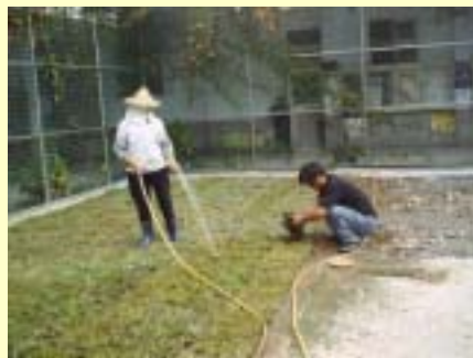
施工中照片-教室前既設pc面層打除 種植草皮日期95.1.6
