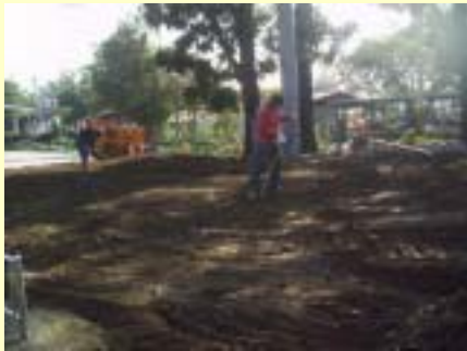
施工中照片-校門右側既設pc面層打除後利用廢土水泥塊堆成土丘-覆蓋沃土日期95.1.5
