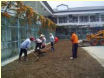
施工中照片-教室前既設pc面層整理 填平沃土日期95.1.5
