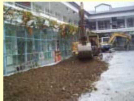
施工中照片-教室前既設pc面層打除 回填沃土日期95.1.2
