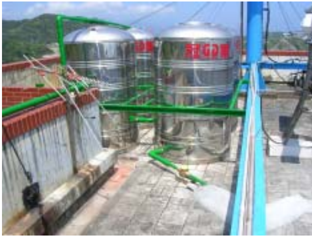
雨水廚水桶、過濾桶安裝固定情形
