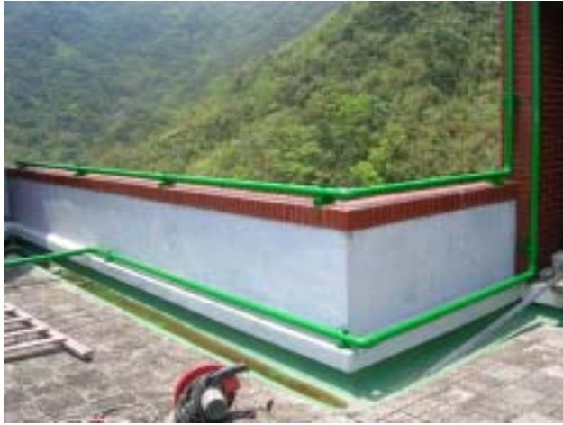
雨水管安裝與固定完成之情形
