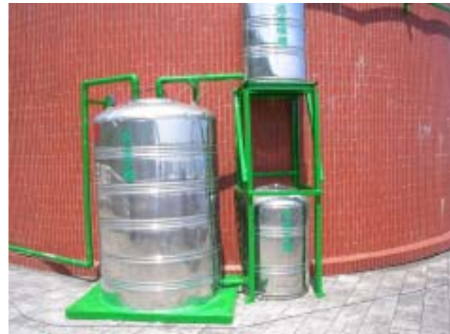
雨水管安裝與固定完成之情形
