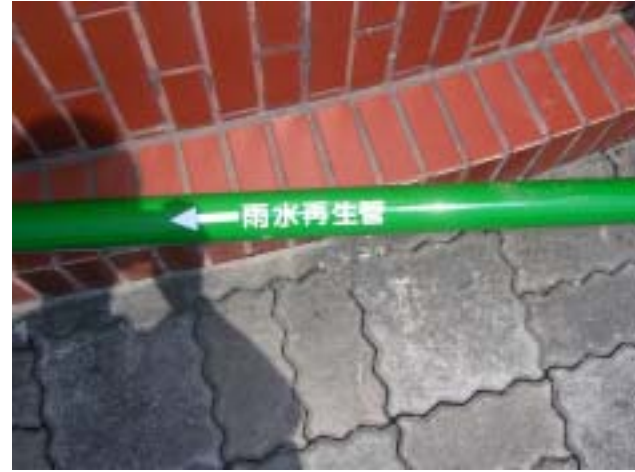
雨水管安裝與固定完成之情形
