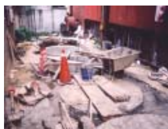
槽曝氣槽施工照片
