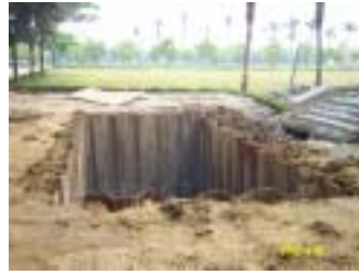
施工中再生水處理設備
