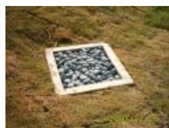
設置雨水浸透井擴大 雨水入滲速度
