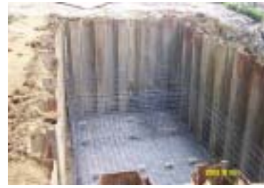
施工中配水槽體底部
