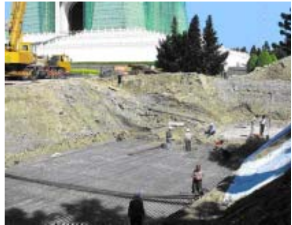
已利用雨水進行澆灌的廣大植栽美化區 具都市防災設計的大型 900 噸貯水槽開挖
