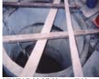
污泥濃縮槽施工照片
