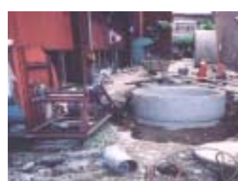
沉澱槽施工照片
