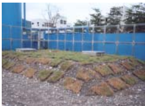
20 噸地下 RC 回收設備貯槽
