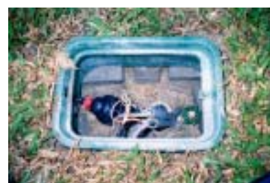
噴灌設備 Y 型過濾器
