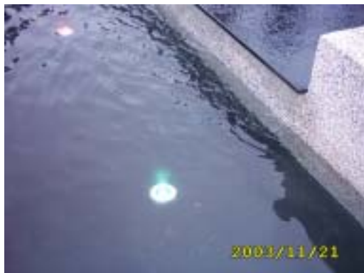
與景觀結合之雨水處理槽 (槽頂)
