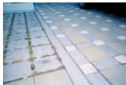
結合溢流雨水設置透水磚擴大應用
