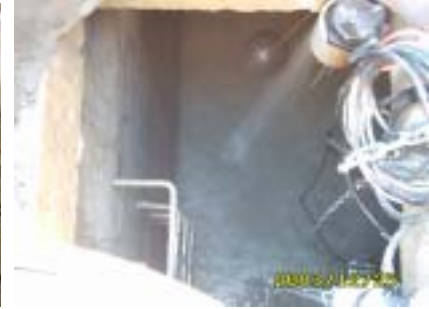
地下雨水貯水槽之進水
