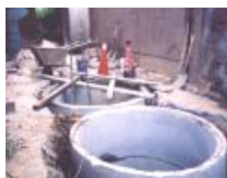
固液分離槽施工照片
