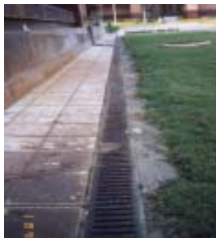
利用現有溝渠接管集水
