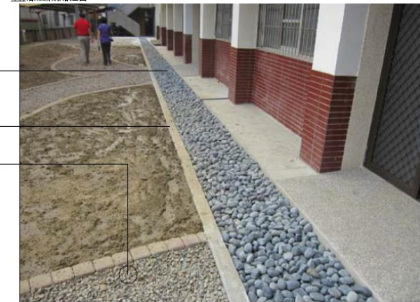
灰色卵石 厚5cm 鍍鋅隔柵板 開孔@4m 銜接水溝 混凝土回收清碎石 混凝土敲除後碎塊 (直徑10cm以下)
